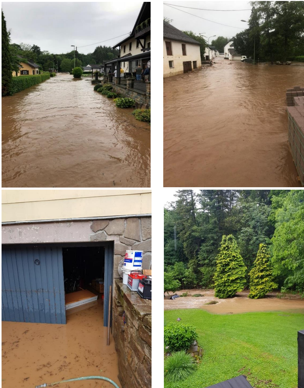
Abbildung 10: Impressionen vom Hochwasser der Irsen am 01.06.2018
