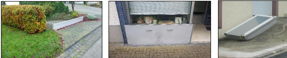
Abbildung 23: Beispiele von Objektschutzmaßnahmen (mobile Steckelemente, Dammbalkensysteme, Abdichtungen)
