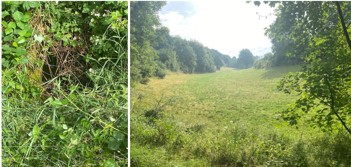
Abbildung 53: links: Durchlass DN 500 unter dem Wirtschaftsweg und rechts: Retentionspotential in der Wiese
