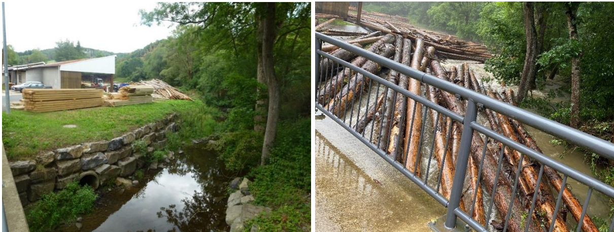
Abbildung 29: nördliche Irßenbrücke, Blick entgegen Fließrichtung zum Sägewerk, links: zum Zeitpunkt der Ortsbegehung, rechts: während des Julihochwassers 2021
