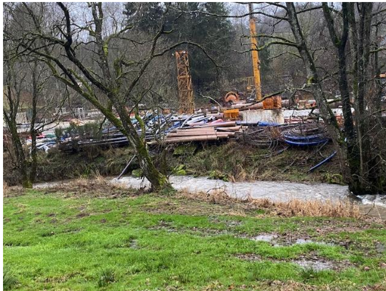
Abbildung 38: Lagerung von Materialien am Ufer des Mannerbaches
