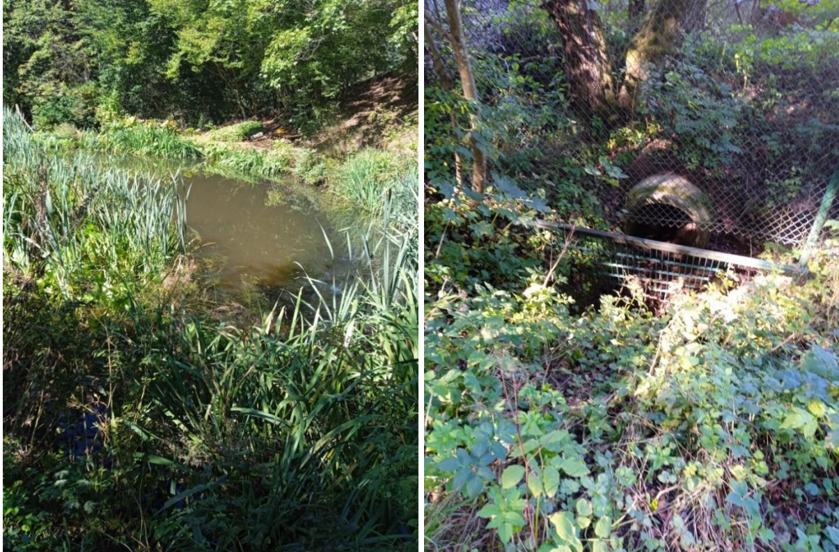
Abbildung 49: links: Fischteiche und Einlauf in die Verrohrung unter dem Wirtschaftsweg und Betriebsgelände
