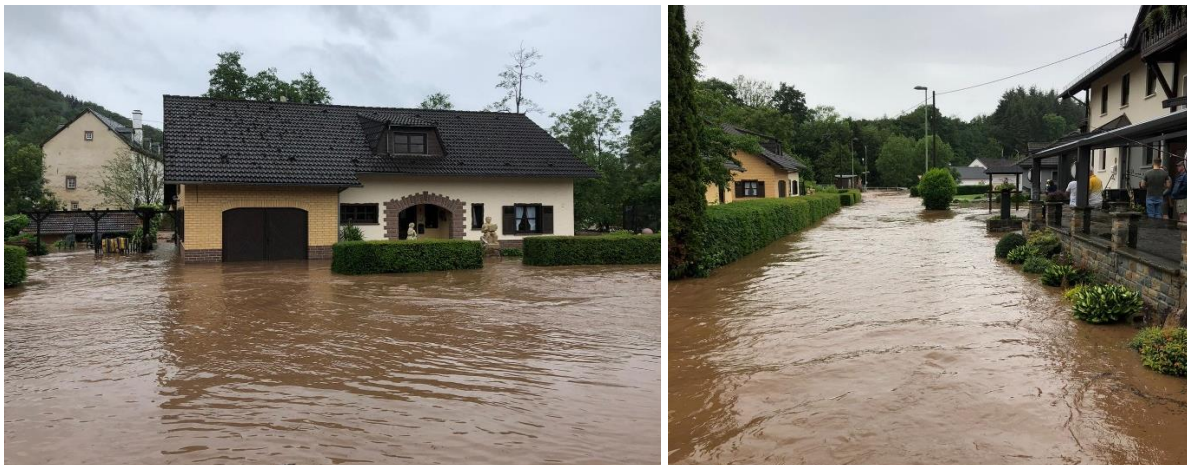
Abbildung 34: Überflutungen in der Straße „Im Pfenn“ in 2018
