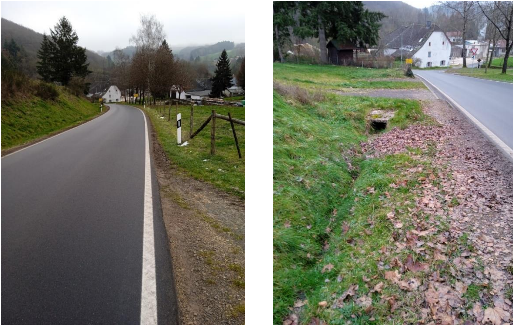
Abbildung 57: Kreisstraße K 147 am Ortseingang Irrhausen, rechts: vorhandenes Einlaufbauwerk
