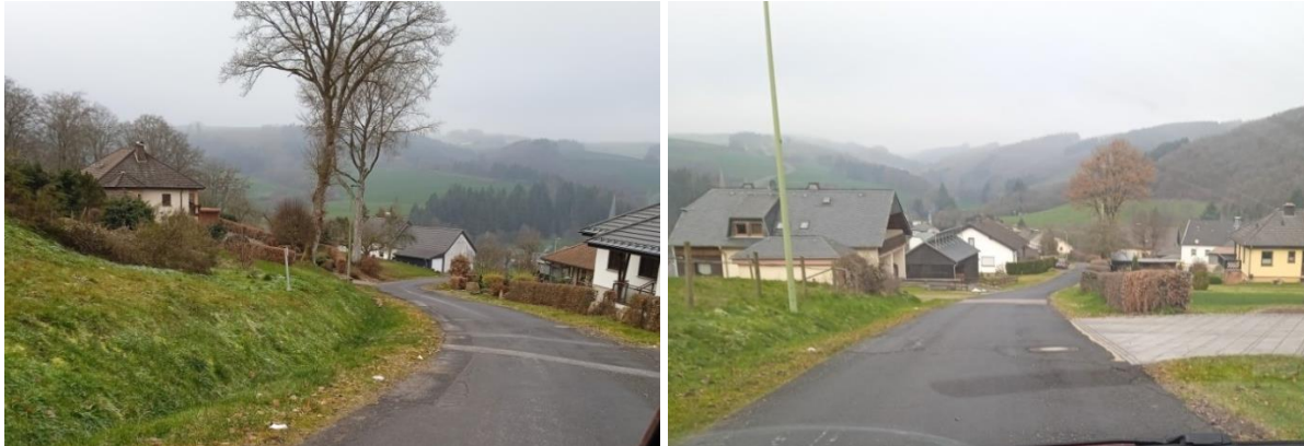
Abbildung 72: Bergstraße mit defizitärer Straßenentwässerung
