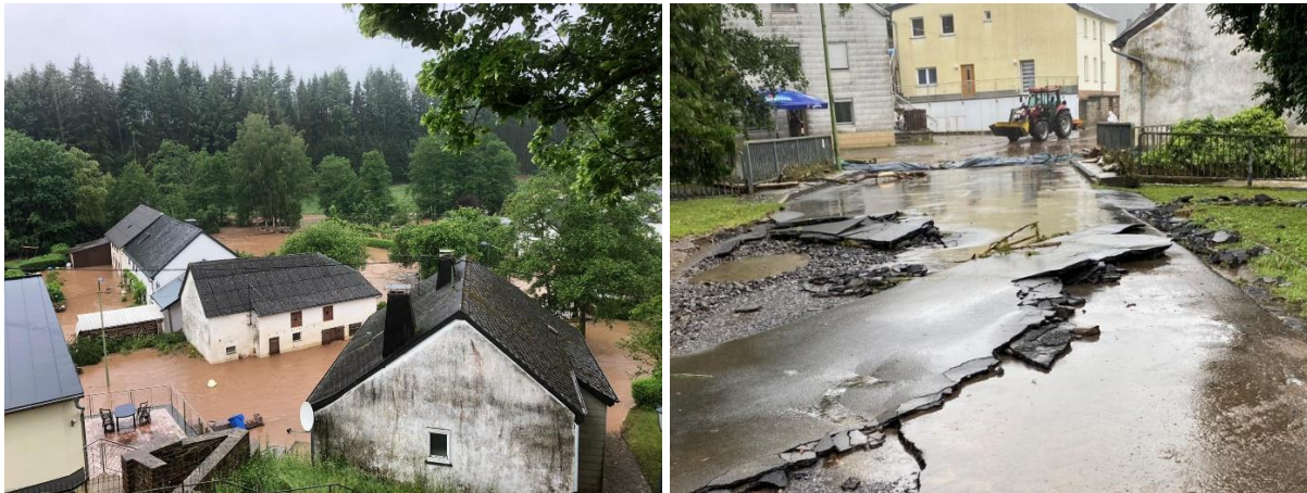
Abbildung 41: links: Überflutungen während des Ereignisses in 2018 im Bereich des Mannerbaches, rechts: Straßenschäden nach Rückgang des Hochwassers in 2021 im Bereich der Mannerbachbrücke
