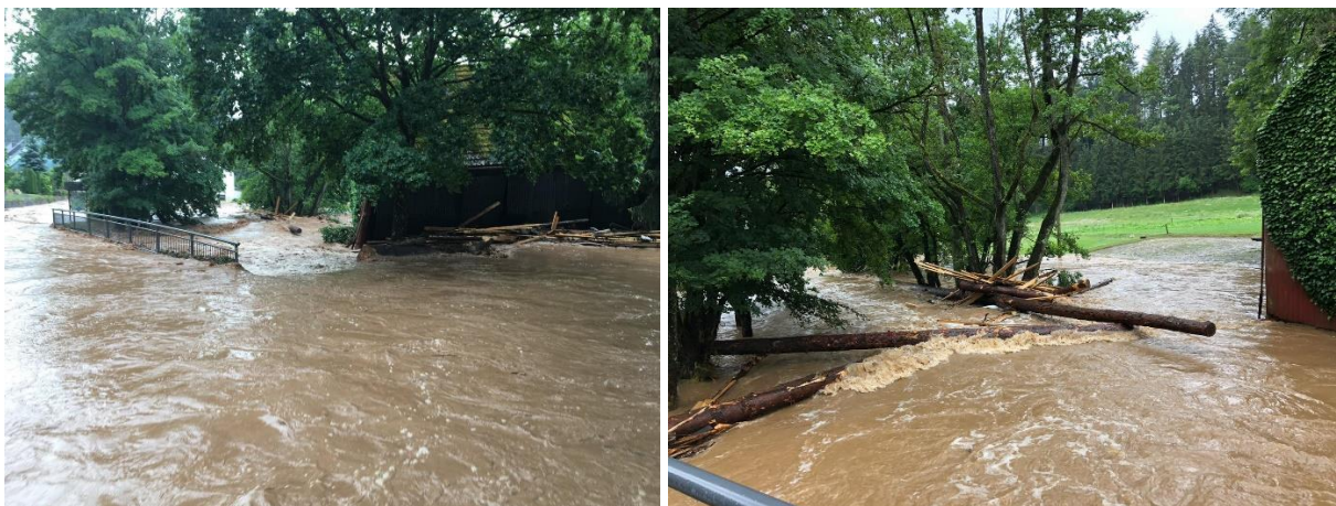
Abbildung 30: großflächige Überflutungen im Bereich der nördlichen Irßenbrücke
