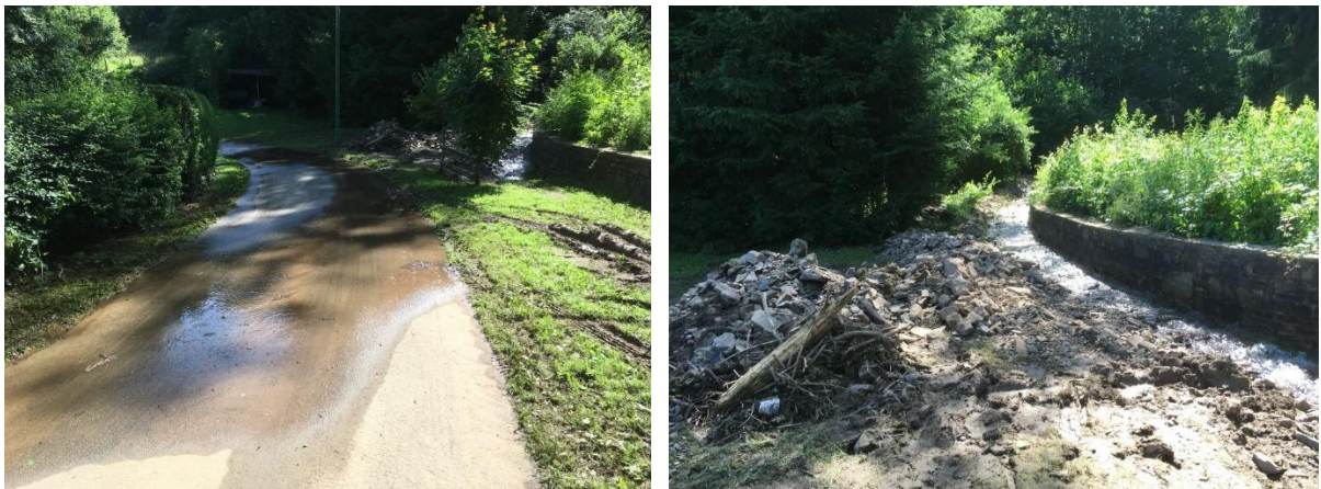
Abbildung 52: Fließweg am Mattelbach und mittransportiertes Geschiebe nach dem Starkregen am 15.07.2021
